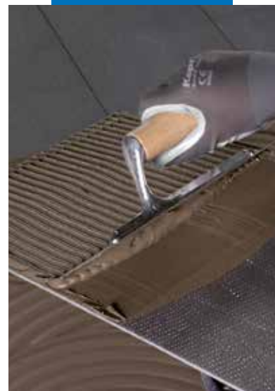
Fordeling af klæbemiddel på bagsiden af fliserne
