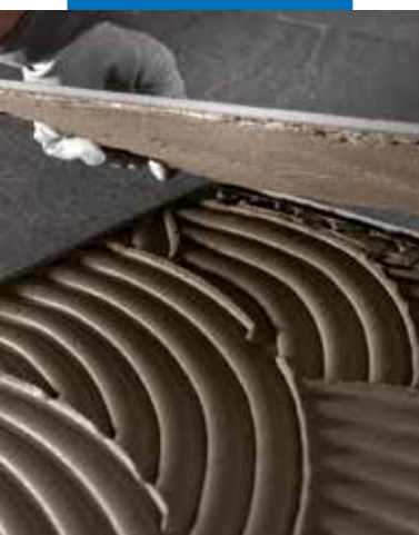
Montering af tynde porcelænsfliser på gulv
